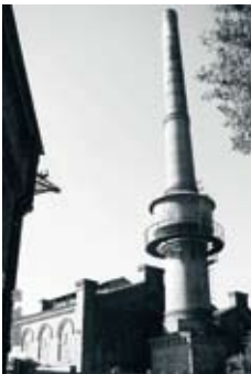
Ein unter Denkmalschutz stehender Kamin der Stadlauer Fabrik der AEG-Union
