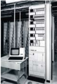
Vorfeld Paketvermittlungs-Konzentrator (VPK-Einrichtung), Prototyp Wien-Arsenal, April 1985
