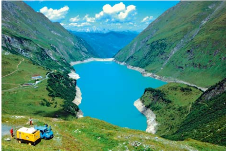
Speicherkraftwerk Kaprun Mooserboden
